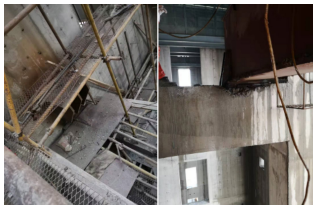
图2 高层建筑内爬塔机内部埋件及牛腿
