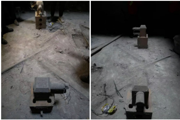
图6 固定基础预埋脚注
