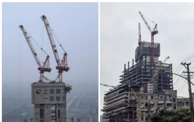
图1 高层建筑内爬与外挂塔机
